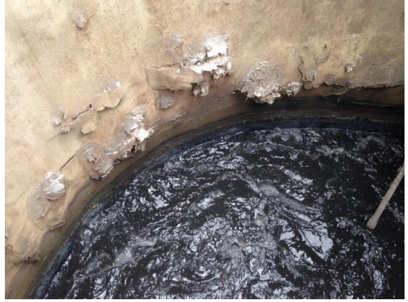
Grit Effluent Channel
